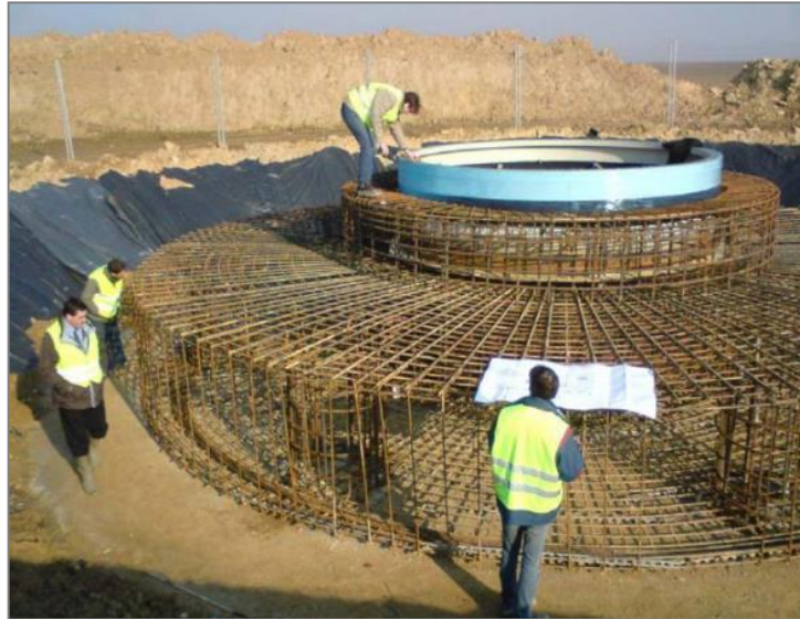
Figure 15 : Ferrailage d'un massif de fondation
