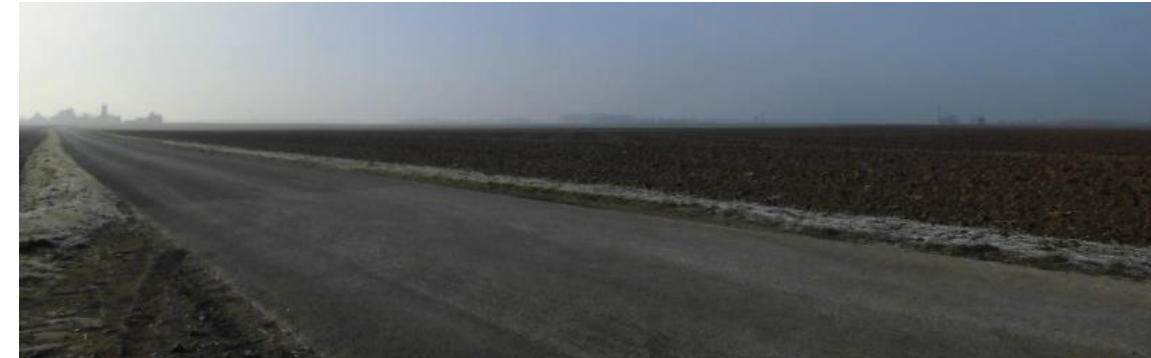
Photographie 7 : Route communale reliant le bourg d'Hancourt à la RD87
