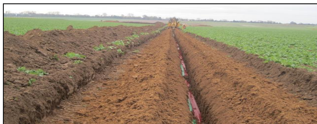
Figure 25 : Vue d'une tranchée de pose de câbles électriques
