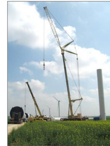
Source : Groupe EUROWATT (Chantier du parc éolien de Bois Louis)
